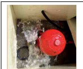
Figure 19 : Schéma de principe et photo du bélier hydraulique du refuge de Presset - Beaufortain (photo P. Mandaroux, schéma www.walton.fr ).
